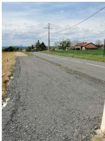
La réparation de la chaussée qui s'était effondrée au niveau du pont de Saint Sulpice s'est faite en deux interventions. Cet affaissement a mis en évidence la fragilité de certaines chaussées vis-à-vis des engins de plus en plus lourds qui les empruntent.
