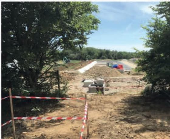
Les travaux de mise en conformité du lagunage sont toujours en cours. Les raccordements aux réseaux d'eau et d'électricité ont été réalisés. Les travaux de mise aux normes du premier bassin sont en cours d'achèvement. Ils devraient se solder courant juin avec une mise en service de celui-ci. La construction d'un local technique devant accueillir les pompes et les différents matériaux servant au fonctionnement du lagunage a débuté. Ils devraient durer jusqu'à la fin de l'été.
